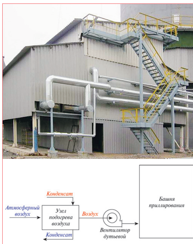
Рис. 6. Общий вид узла подогрева атмосферного воздуха
